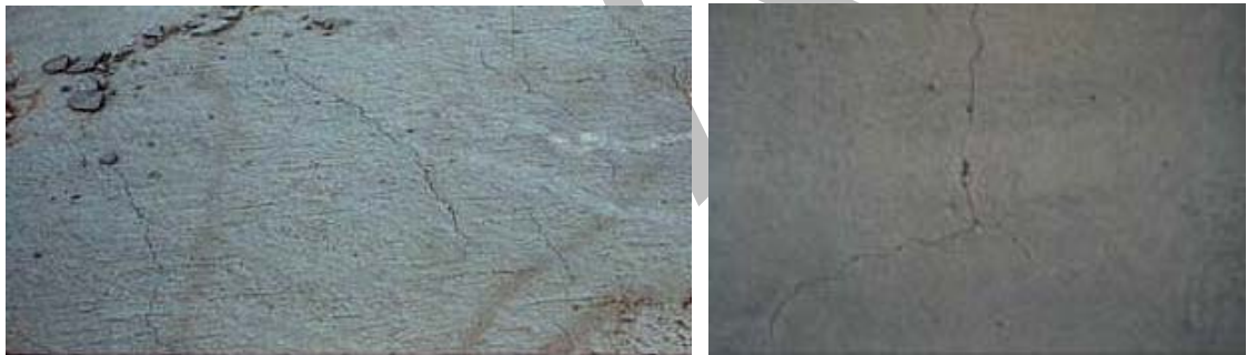
Φωτ 1: Ρηγμάτωση σκυροδέματος σε πλαστική κατάσταση
