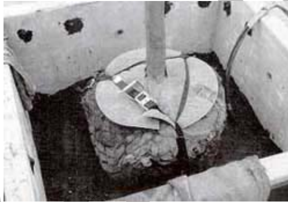
Εκόνα 3.1. Υπόγεια στήριξη δένδρου με χρήση γεωυφάσματος
