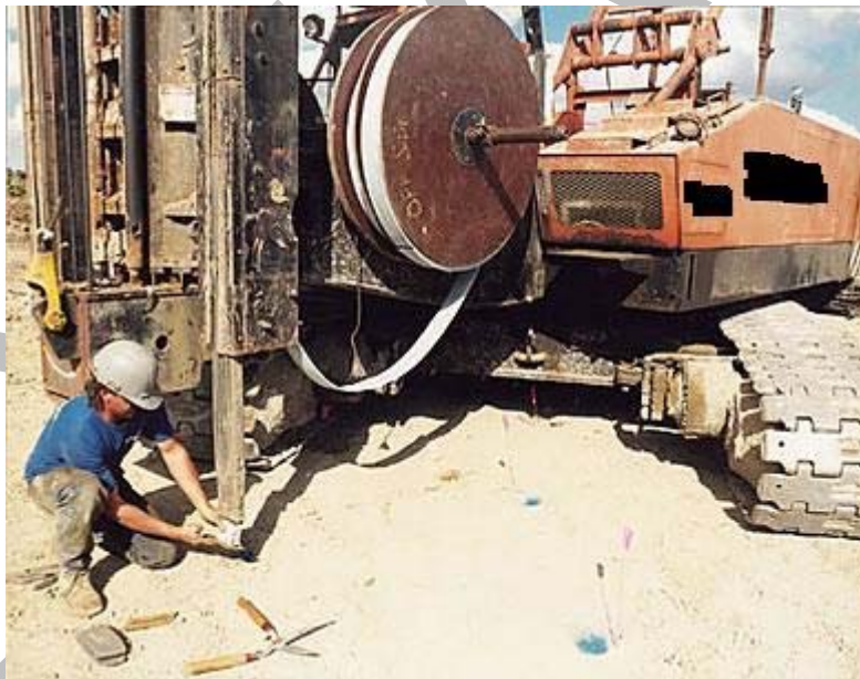
Σχ. 3: Εξοπλισμός τοποθέτησης κατακόρυφων στραγγιστηρίων.
