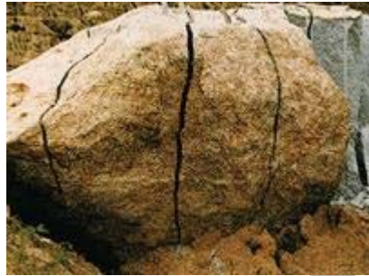
Σχήμα 1: Διάσπαση υλικών με διογκούμενα υλικά (αθόρυβα εκρηκτικά)
