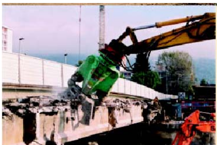
Σχήμα 3: Καθαίρεση φορέα οπλισμένου σκυροδέματος με υδραυλική σιαγόνα βαρέως τύπου
