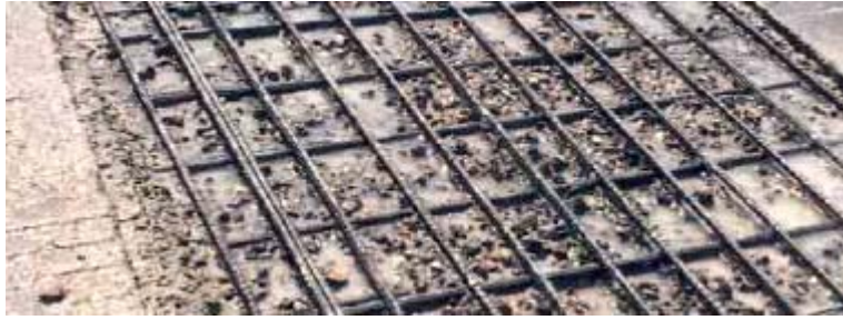
Σχήμα 3: Αποδιοργάνωση σκυροδέματος και αποκάλυψη οπλισμού με υδροκοπή (hydrodemolition)
