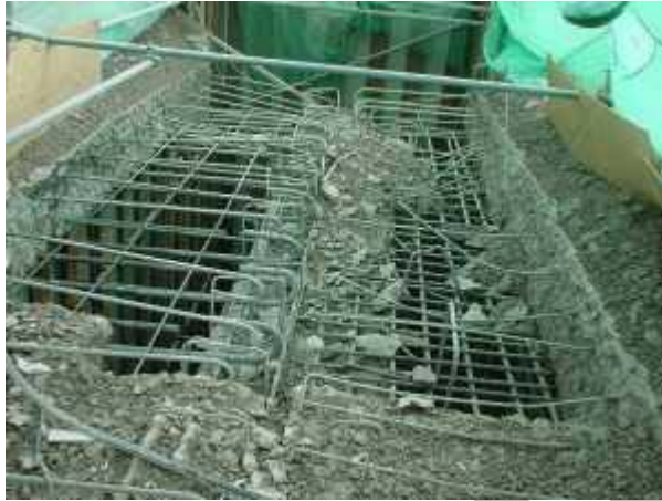
Σχήμα 1. Αποσύνθεση πλάκας οπλισμένου σκυροδέματος με υδροκοπή (hydrodemolition) με ταυτόχρονη αποκάλυψη του οπλισμού
