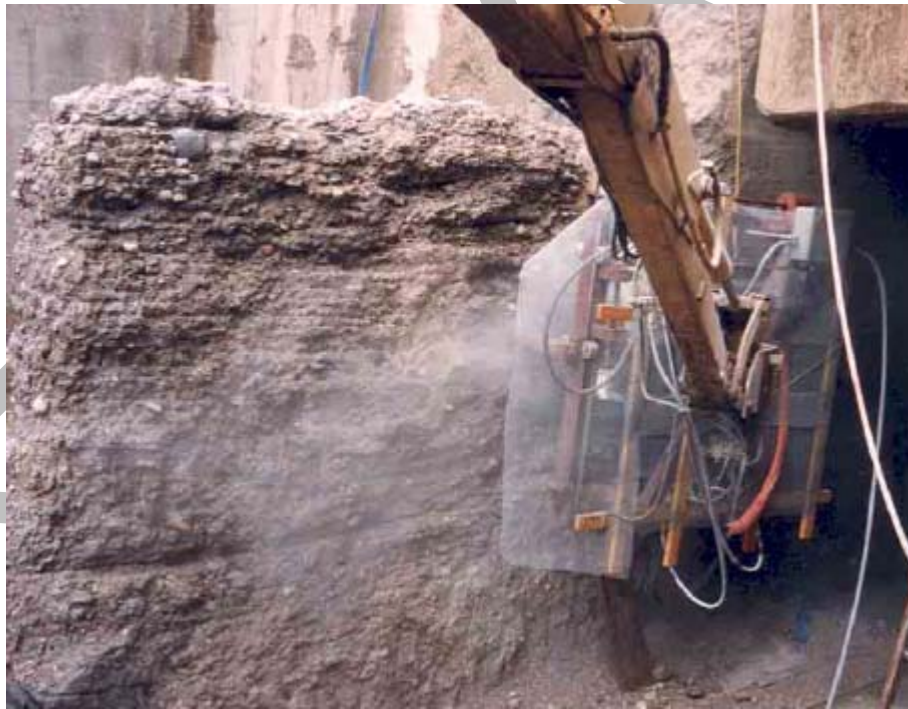
Σχήμα 2: Αποδιοργάνωση σκυροδέματος με υδροκοπή (hydrodemolition) σε κάθετη επιφάνεια (Χρήση εξοπλισμού με ρομποβραχίονα)
