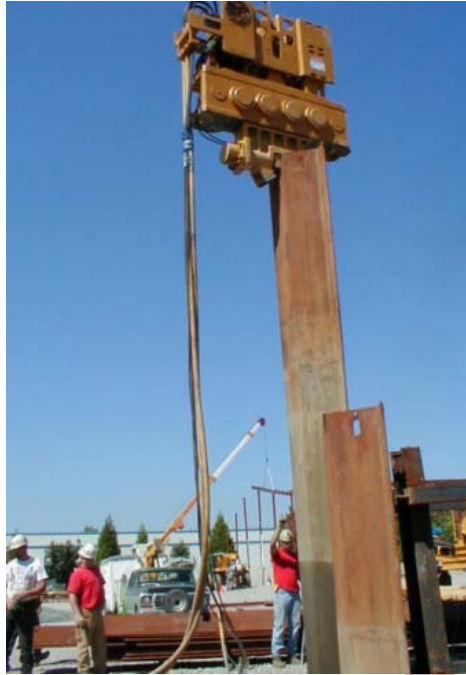
Σχήμα 3: Εξόλκωση τμήματος πασσαλοσανίδας με την χρήση δονητικού πασσαλοπήκτη/ εξολκέα και γερανού
