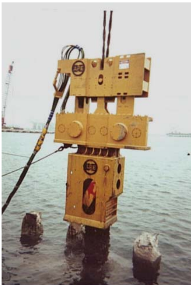
Σχήμα 2: Εξόλκωση πασσάλων από οπλισμένο σκυρόδεμα με την χρήση δονητικού πασσαλοπήκτη/ εξολκεία
