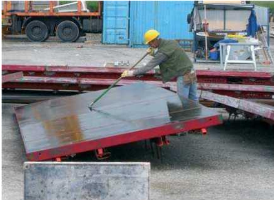
Εικόνα 1 - Ομοιόμορφη εφαρμογή αντικολλητικού με λαστιχένια σπάτουλα
