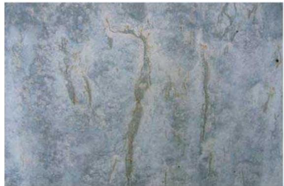
Εικόνα 4 - Χρωματικές αλλοιώσεις λόγω υπερδοσολογίας αποκολλητικού
