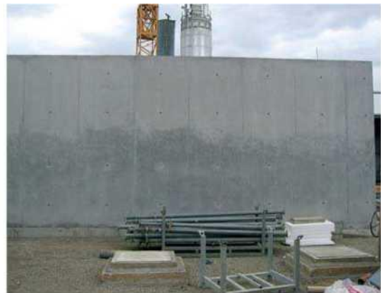
Εικόνα 8 - Εμφανής διαφορά απόχρωσης (μη αποδεκτή)
