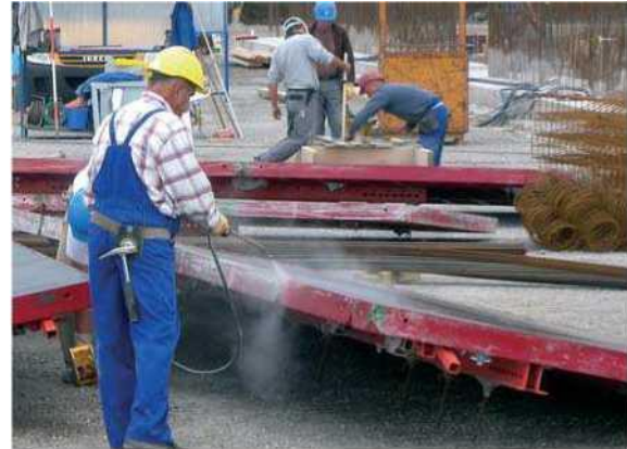
Εικόνα 2 - Εφαρμογή αντικολλητικού με ψεκασμό
