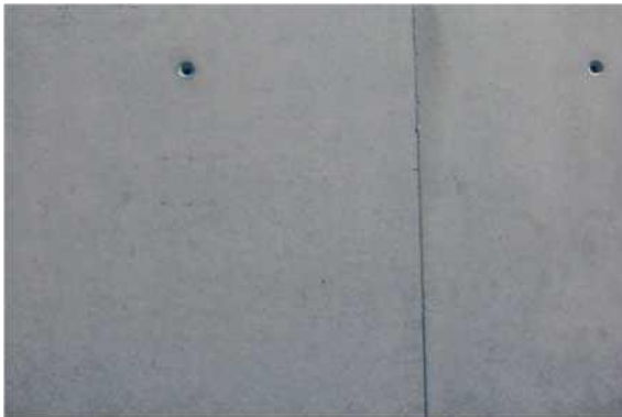
Εικόνα 3 - Η σωστή δοσολογία του αποκολλητικού είναι ουσιώδης
