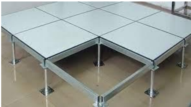
Σχήμα 1 - Συστατικά μέρη ενός υπερυψωμένου δαπέδου
