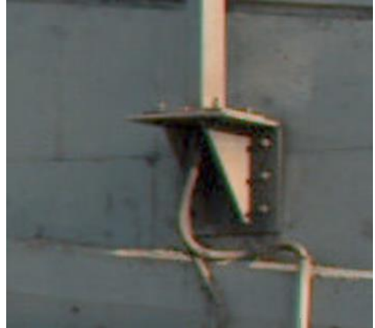
Εικόνα 4: Χαλύβδινη διάταξη στήριξης ιστού σε όψη τοίχου
