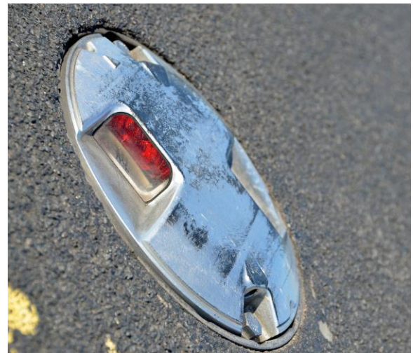
Εικόνες 2 και 3 - Παραδείγματα χωνευτών φανών διαδρόμων αεροδρομίου.
