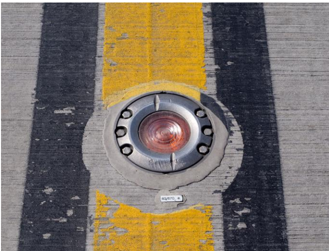
Εικόνες 2 και 3 - Παραδείγματα χωνευτών φανών διαδρόμων αεροδρομίου.
