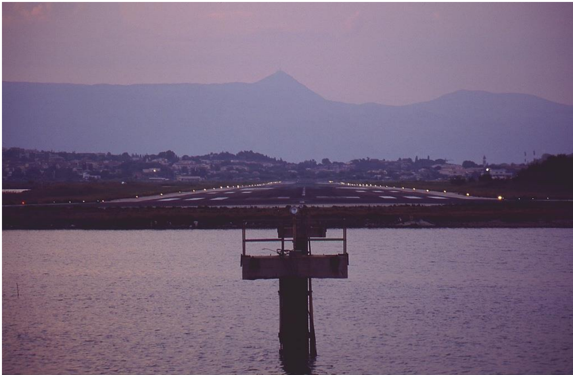
Εικόνα 1 - Διάδρομος αεροδρομίου με αναμμένα τα πλευρικά υπερωρωμένα φωτιστικά.
