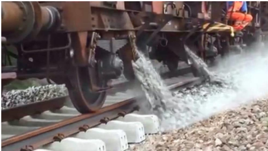
Εικόνα 2: Σκυρόστρωση
