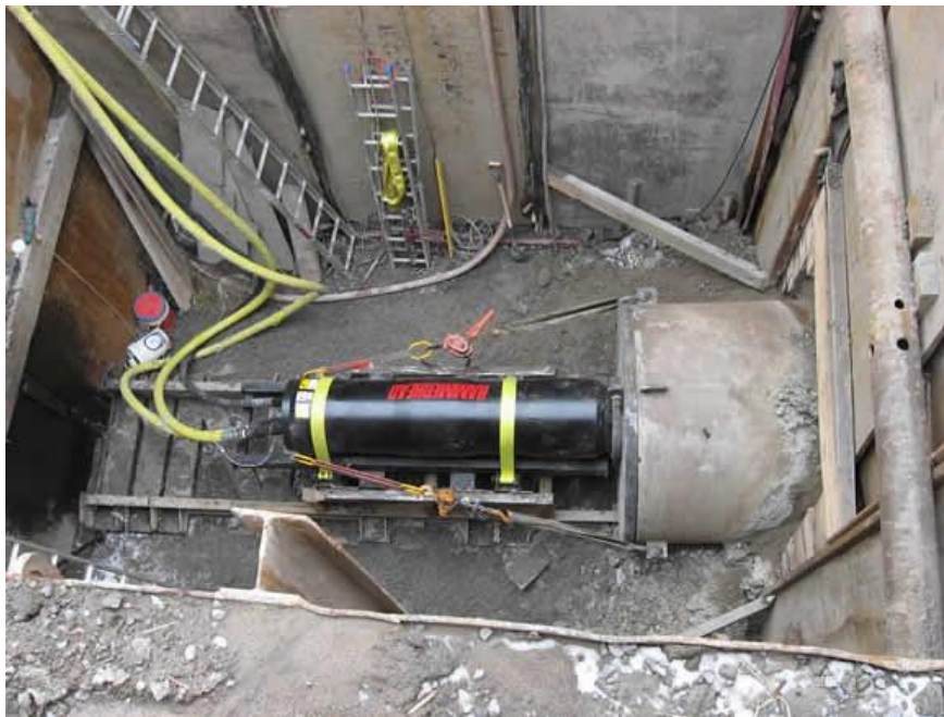
Εικόνα 1 : Τυπική διάταξη κρουστικής έμπηξης ανοικτού σωλήνα
