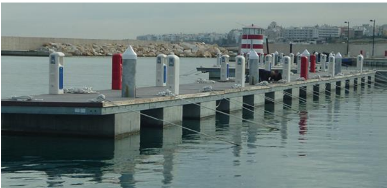
Εικόνα 3: Τυπικό σύστημα αγκύρωσης πλωτού προβλήτα
