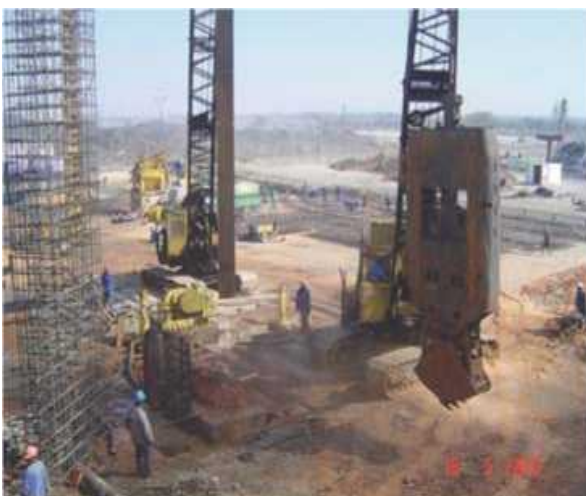
Εικόνα 3 - Αρπάγες μηχανικής λειτουργίας με συρματόσχοινο (μπένες)
