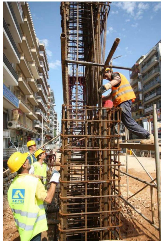
Εικόνες 6, 7 και 8 - Διαδικασία τοποθέτησης κλωβού οπλισμού
