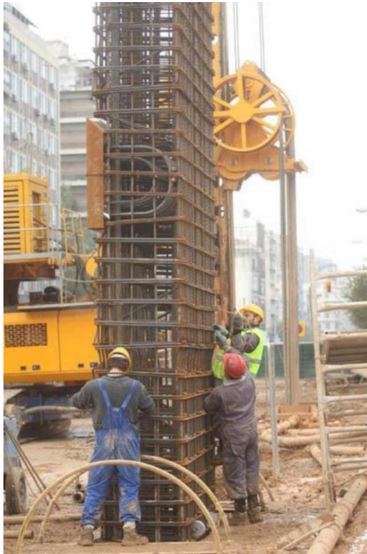
Εικόνες 6, 7 και 8 - Διαδικασία τοποθέτησης κλωβού οπλισμού
