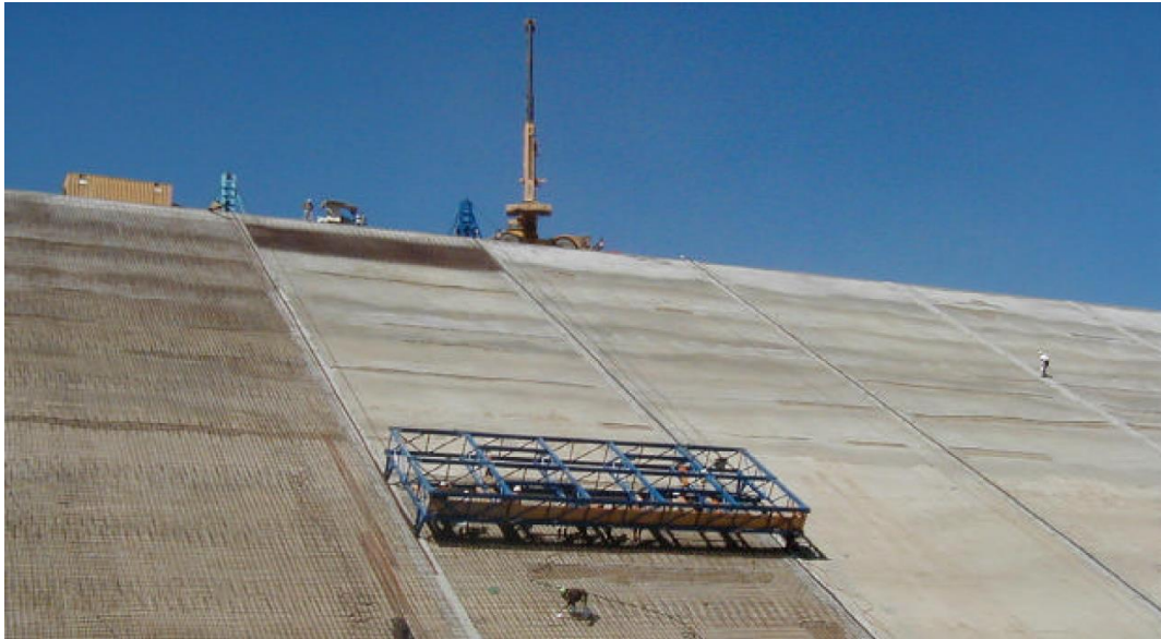
Εικόνα 3 - Τυπικό φορείο τοποθέτησης σιδηροπλισμού
