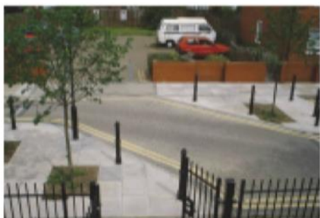
Πάνω και κάτω, οριζόντια μετατόπιση με περιοριστή ταχύτητας
